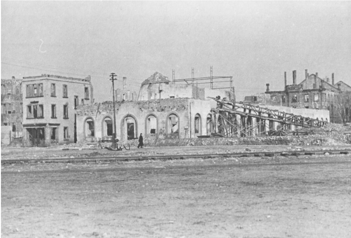
Abb. 50: Zeughaus nach der Zerstörung (um 1945)
