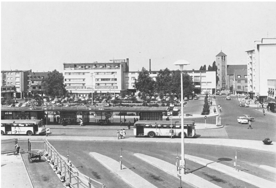
Abb. 68: Busbahnhof - im Vordergrund Bauarbeiten für Wartehäuschen auf dem Dreieck (1961)
