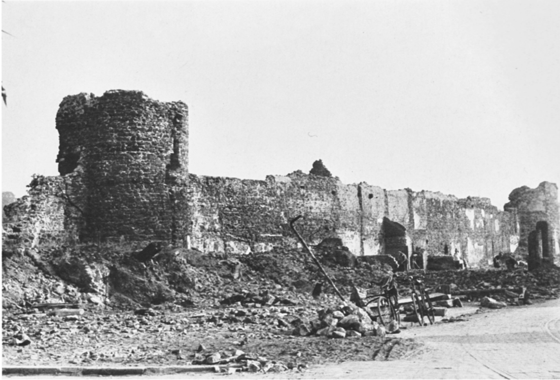
Abb. 44: Stadtmauer in der Nordstraße (1949)
