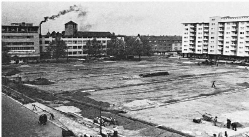
Abb. 72: Beginn der Bauarbeiten für Parkplatz am Freiheitsplatz (1959)
