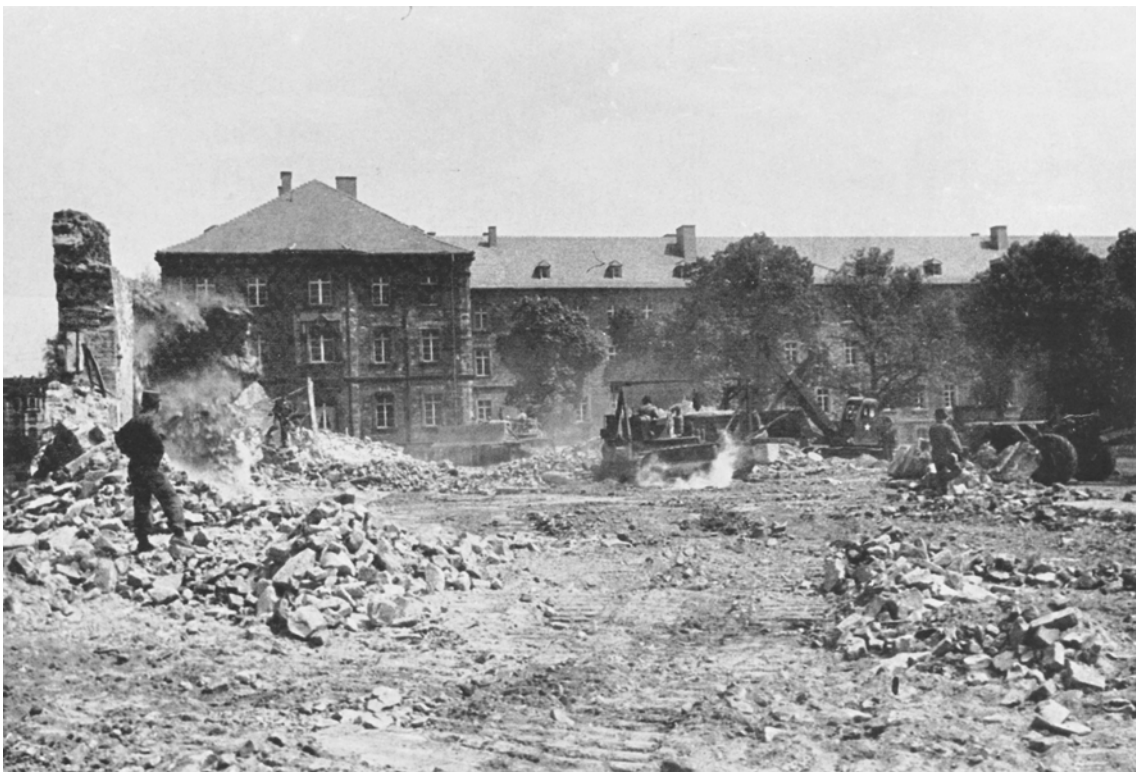
Abb. 51: Abbruch des Zeughauses durch amerikanische Pionier-Einheiten - im Hintergrund das wiederaufgebaute Behördenhaus (1954)
