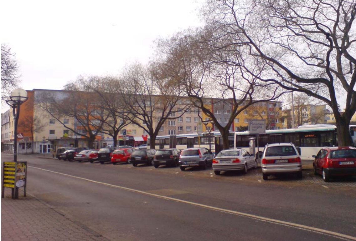
Abb. 38: Blick auf Südostseite, Wohn- und Geschäftshaus Seidenspinner (2010)
