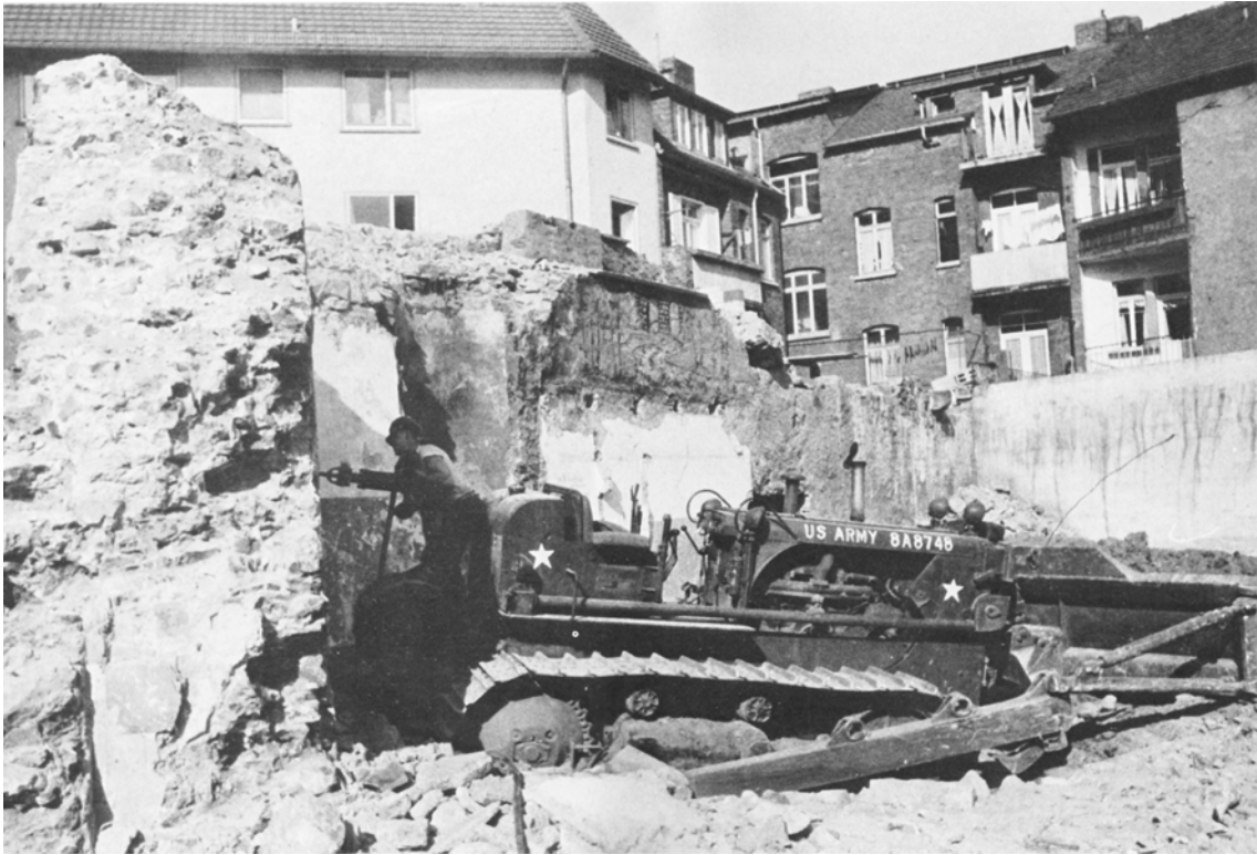
Abb. 46: Abbruch der Stadtmauer in der Marktstraße durch amerikanische Pionier-Einheiten (1960)
