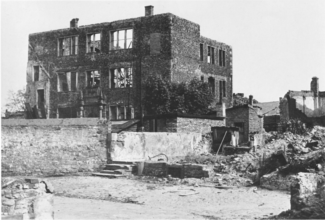
Abb. 52: Blick aus der Großen Dechaneigasse auf das ausgebrannte Schulgebäude der Alten Hohen Landesschule (1949)
