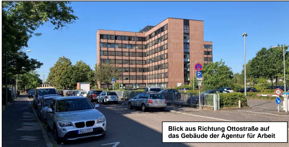
Abb. 14: Gebäude der Agentur für Arbeit
